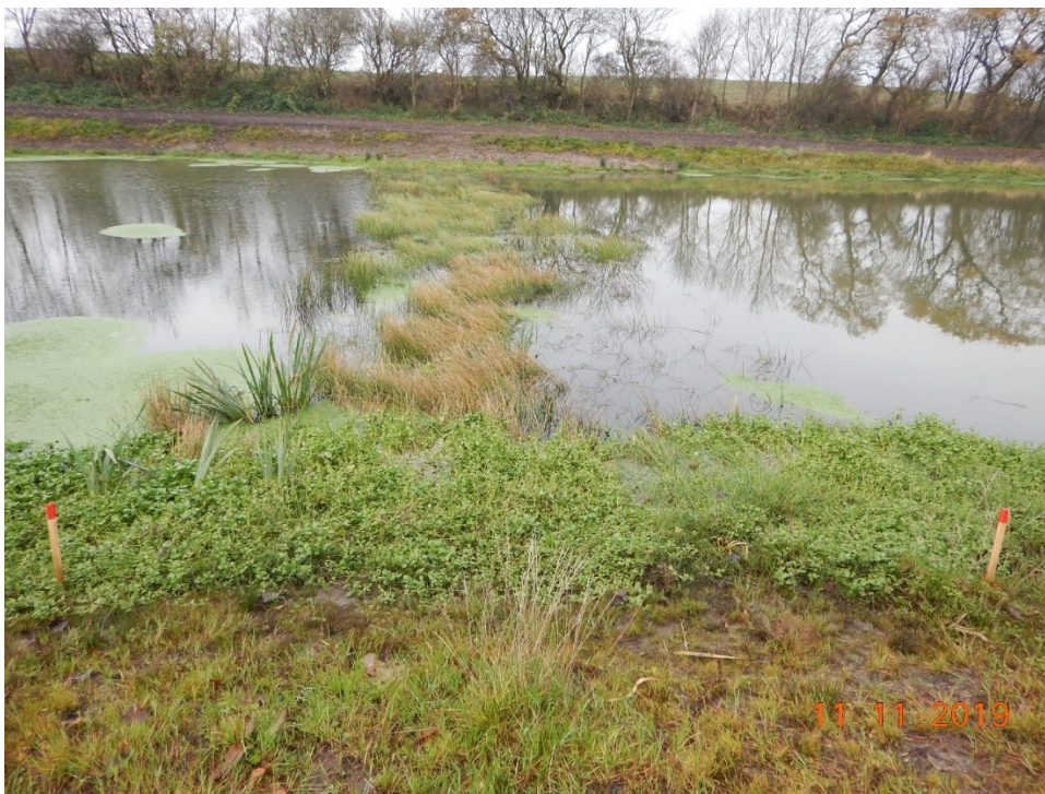
Figur 4.8 Her ses en beplantet bræmme mellem sedimentationsbassin og 1. dybe zone.
