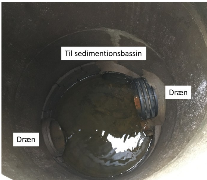
Figur 4.2 Drænrørene samles i en samlebrønd inden sedimentationsbassinet
