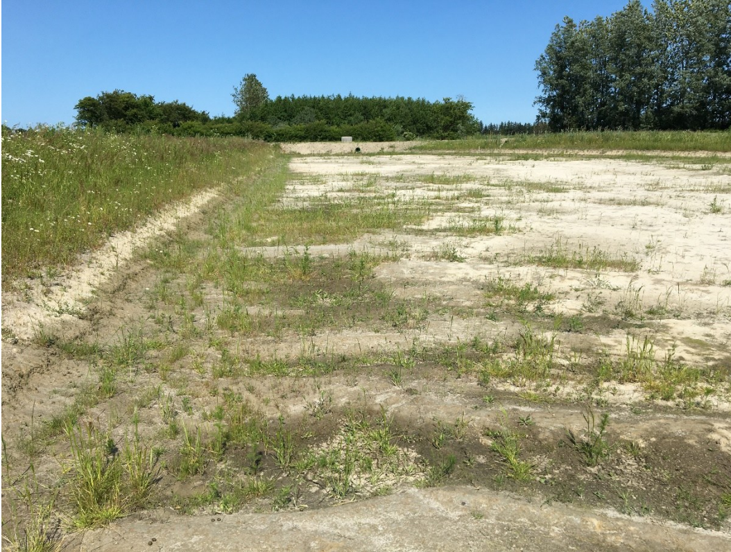
Figur 4.13 Minivådområdets bund (uden lermembran) før vandpåfyldning.
