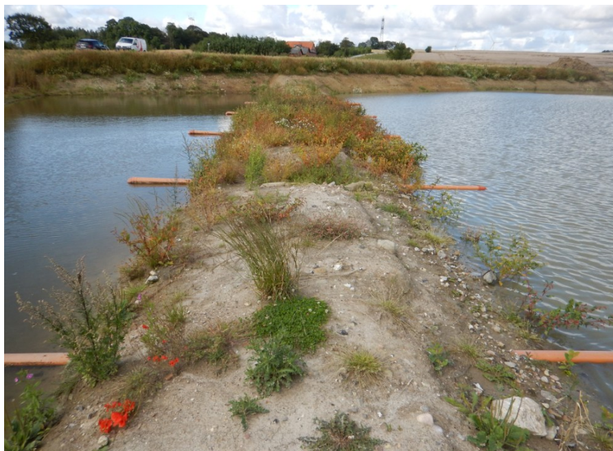
Figur 7.3 - Bræmme med rørføring
