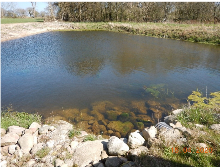
Figur 4.6 Sedimentationsbassinet opsamler sediment og bundfælder fosfor.
