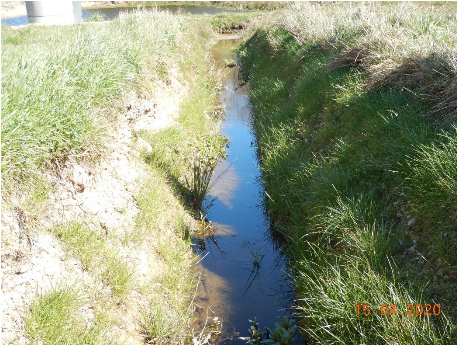
Figur 4.4 Grøft med vand.
